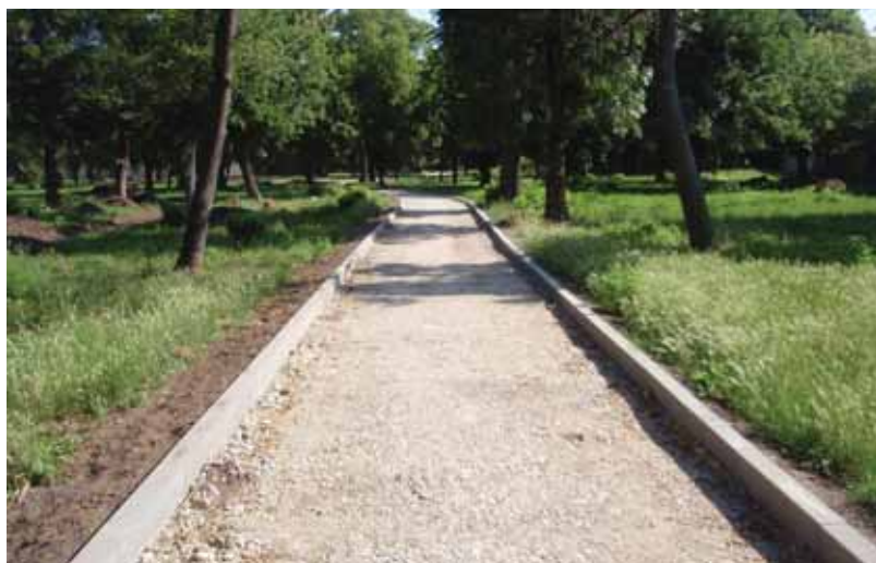
Výkopové práce komunikácií po ich vytýčení a osadenie obrubníkov do betónového lôžka Földmunkálatoka kimérés után a járgaszévelyek beépítése a betonágyzatba.
